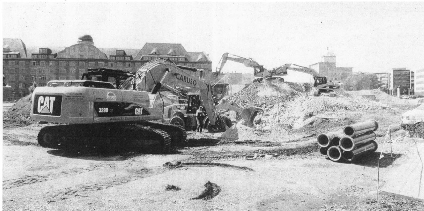
Für maximale Verfügbarkeit und Kostensicherheit wurde für alle Geräte ein Full-Service-Wartungsvertrag mit Zeppelin Leipzig abgeschlossen.
