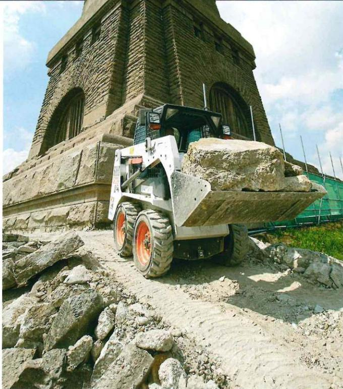
**D**as historische Völkerschlachtdenkmal in Leipzig wird mithilfe von modernen Baumaschinen aus dem HKL MIETPARK saniert: Die Caruso Umweltservice GmbH setzt Kompaktlader und Minibagger für Abbruch- und Transportarbeiten ein.
