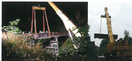
Nachdem alle Sicherungs- und Schutzmaßnahmen abgeschlossen waren, wurde das erste Mittelteil der Brücke angeschlagen und mittels Wandsäge getrennt. Die beiden Seitenteile folgten ohne Verzögerung. Das größte Brückenteil brachte es dabei immerhin auf ein Gewicht von 36 t. Für die Betonsägearbeiten war von der Firma Caruso ein an-
