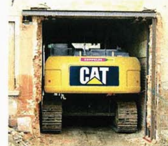
Nur etwa fünf Zentimeter Luft blieben zwischen Bagger und Hausmauer.
