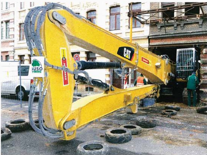
Stück für Stück bewegte der Maschinenführer den Bagger rückwärts durch die Toröffnung. Fotos: Zeppelin Rental
