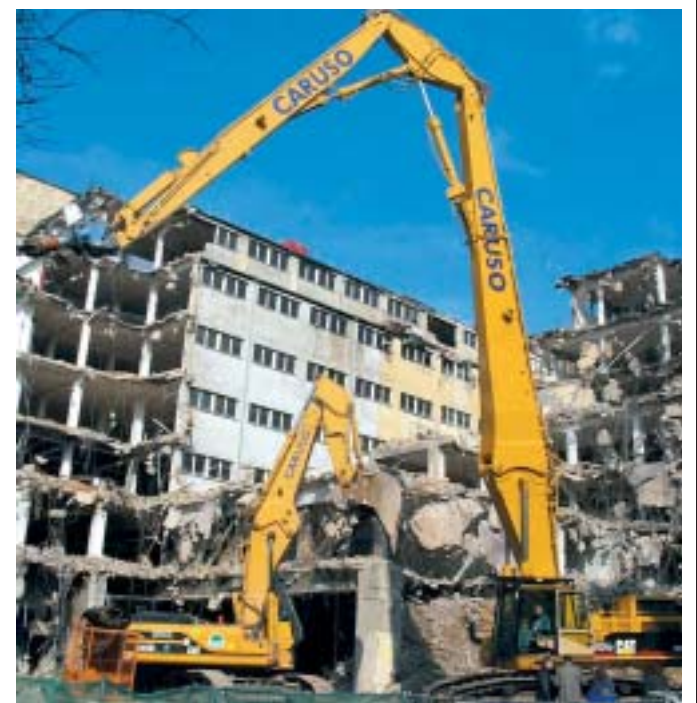
Der Superlongfront-Bagger der Firma Caruso bei Abbrucharbeiten am Leipziger Petershof.
