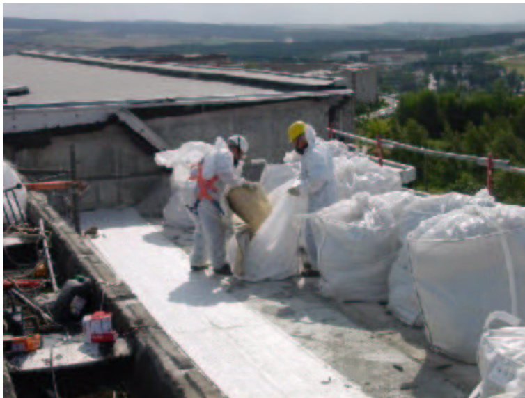
Bild 23: Hineinheben der Fasermatte in den Big-Bag, was i. d. R. allein erfolgt
