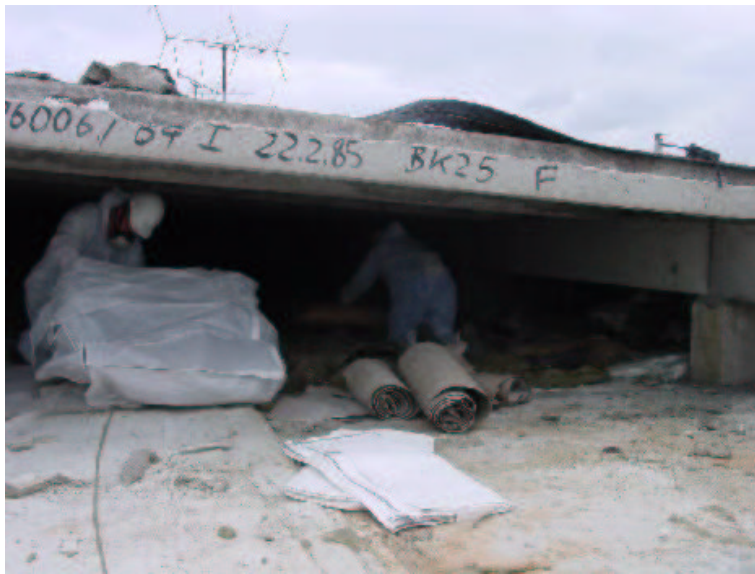
Bild 26: Befüllen des Big-Bag im Knien
