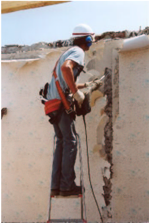
Bild 17: Statische Haltearbeit beim Aufstemmen von Fugen mittels 12 kg schweren Abbruchhammers
