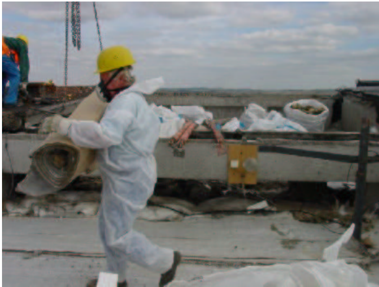
Bild 22: Transport der aufgerollten Fasermatte zum Big-Bag
