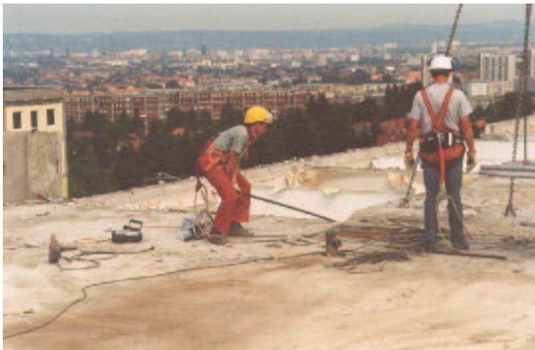
Bild 18: Lockern der Deckenplatten durch manuelles Hebeln mit der Brechstange
