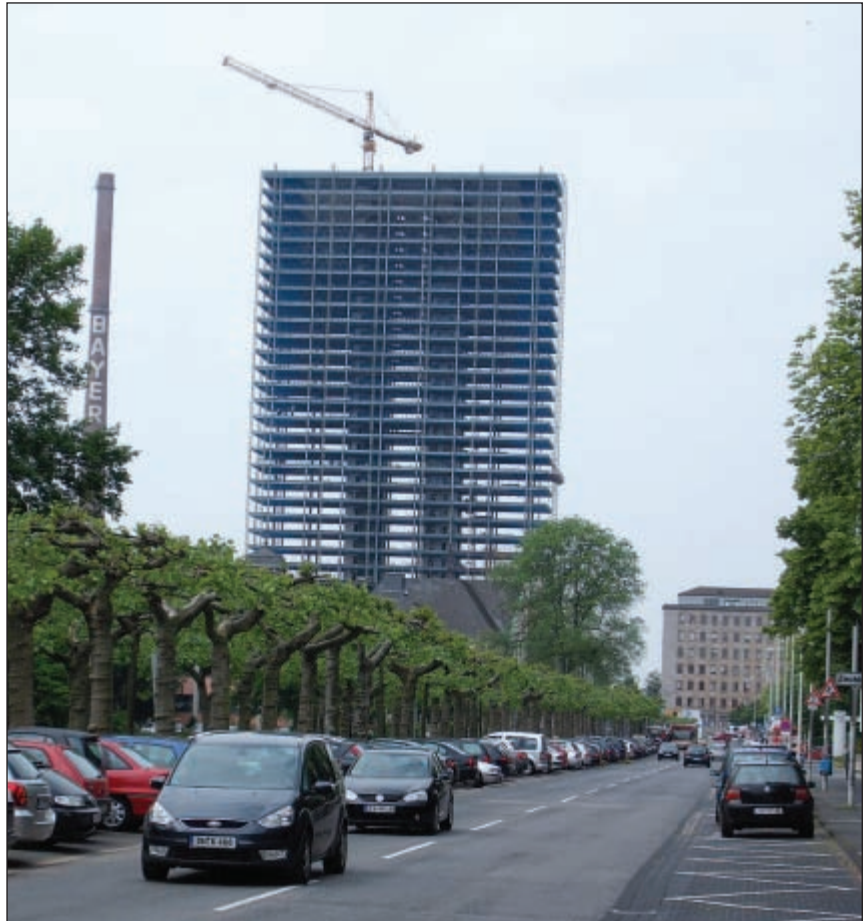
Abb. 4: Entkerntes Bürohochhaus der Bayer AG
