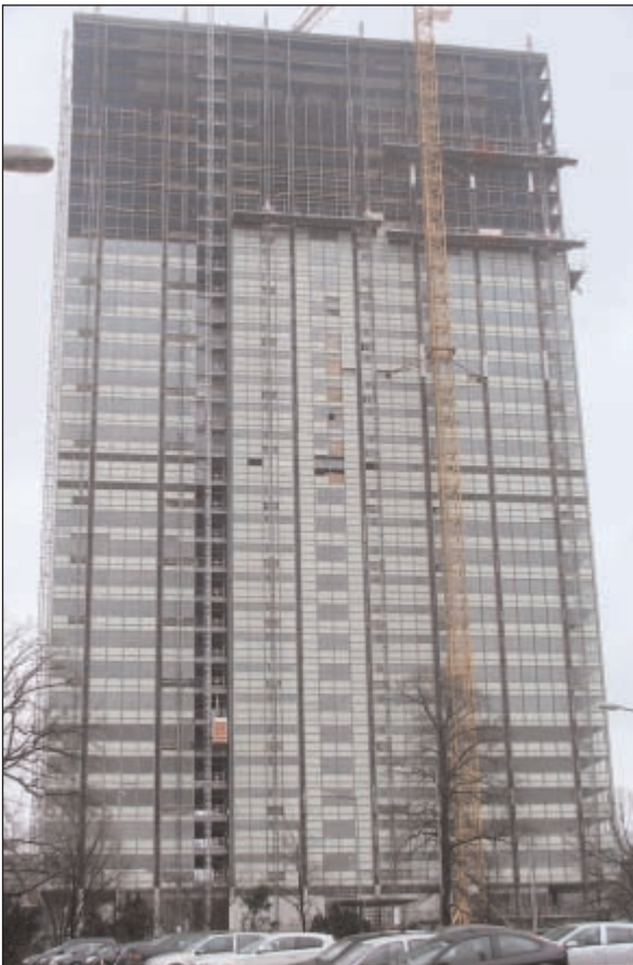
Abb. 3: Einsatz von acht Personenaufzügen als Transportmittel für 10.000 t separierte Abbruchmassen
