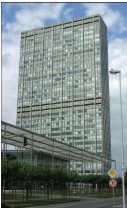
Abb. 1: Bürohochhaus der Bayer AG, Hauptsitz Leverkusen
