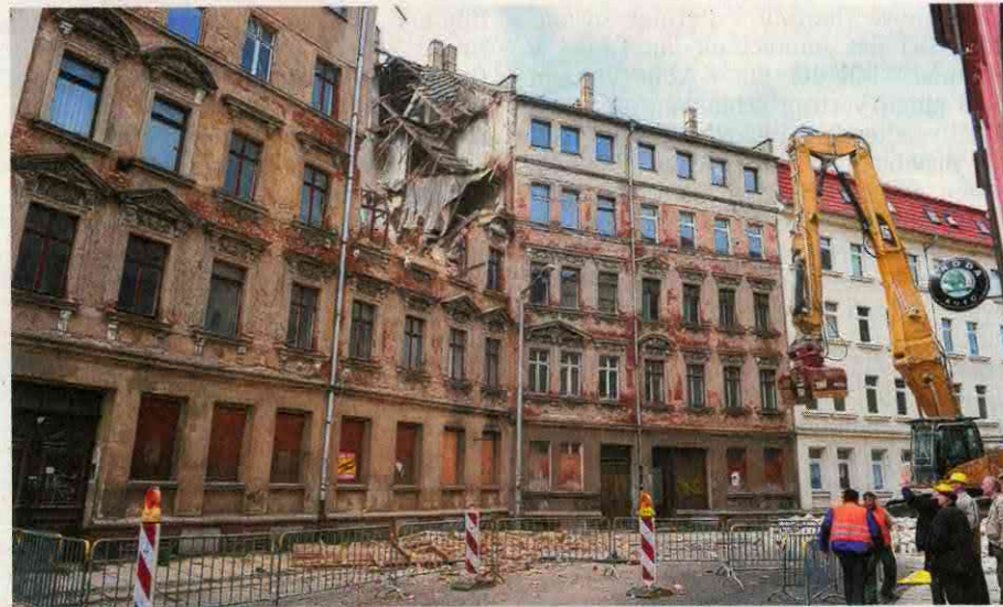
Einsturzstelle Bernhardstraße gestern Nachmittag: Für Haus Nummer 15 gibt es keine Rettung mehr, es muss abgerissen werden. Foto: Wolfgang Zeyen
