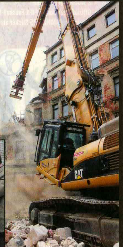
15.50 Uhr begann ein Bagger mit dem endgültigen Abriss des halb eingestürzten Hauses
