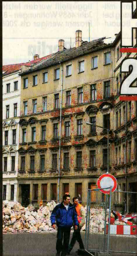
Nachdem die Rückseite des Gebäudes eingestürzt war, wurde die Straße abgesperrt
