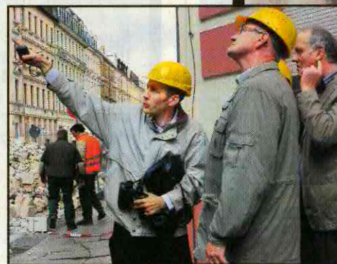
Mitarbeiter des Bauordnungsamtes begutachten den Schaden in der Bernhardstraße
