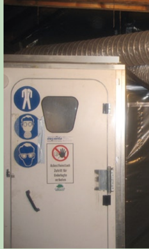
Bild links: Einsatz einer 4-Kammer-Personalschleuse zur Asbestsanierung Bild rechts: Komplett einhausung und Unterdruckhaltung, Regelungsbehörde für Telekommunikation und Post in Dresden
